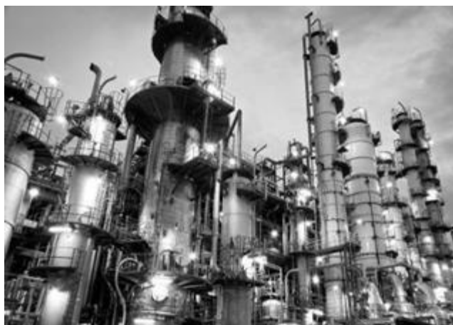
Torres de destilação fracionada em uma refinaria de petróleo.
